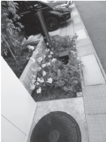
図表11 配電線を地下に収めた管渠の上部
