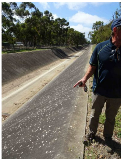
(写真2) 洪水放水路
