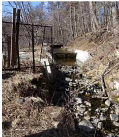
（写真 2）蓼科第 3 発電所の取水堰と取水前の用水路
