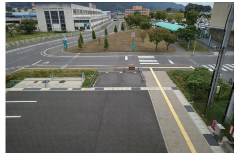
(地下には熱交換パイプが埋め込まれている)
