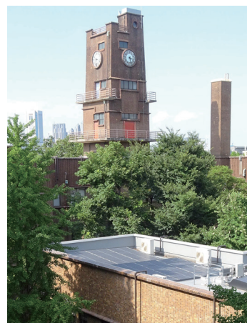
東大先端研の屋上PVパネル。低層の伝統建築で、周辺の最近の研究棟から見下ろせるため、光害を及ぼさないような機種が選ばれた
