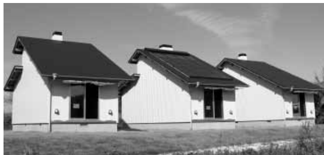
左から順に液体式集熱実験棟、空気式集熱実験棟、一般住宅（比較用）（NEDO「太陽熱エネ活用型住宅技術開発事業」で実施中）
