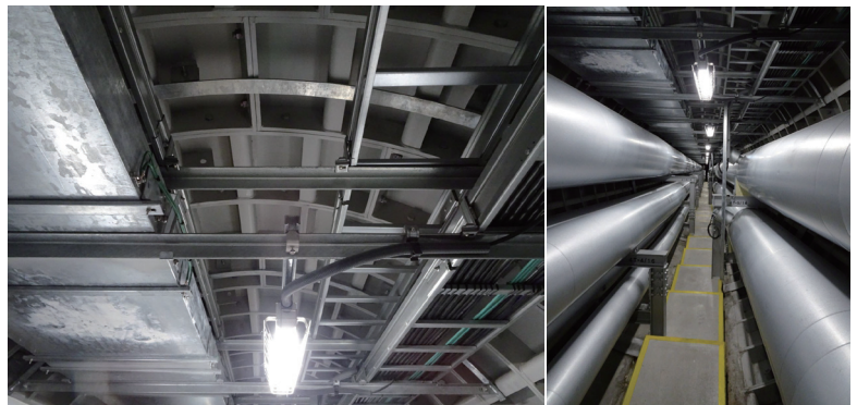
（有楽町地区の新洞道（Big Tube）の内部）
