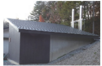
(蓼科東急リゾートのバイオマス温水ボイラー)
