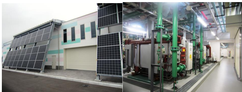
図3 新地エネルギーセンターの外観（左）と内部の熱供給システム（右）
