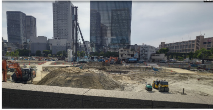
南公園に造成中の池
