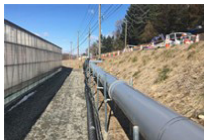
排気導管を通じてCO 2 を栽培温室に供給
