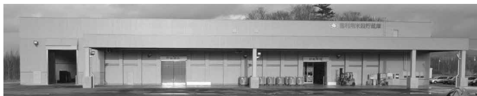
雪冷熱の米貯蔵庫。左の開口部が貯雪庫で、そこからの冷気が米貯蔵庫に導かれる。
