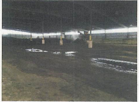
ネイバービル市下水処理のコンポスト汚泥置き場
