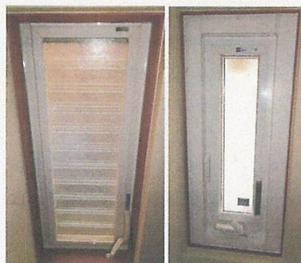
改修前のジャロジー窓(左)と断熱改修後
