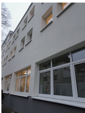
＜写真4＞壁を付加して（厚くして）断熱を強化した事例
