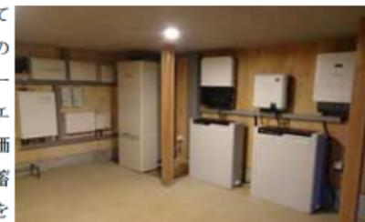
（金山デッキのスマートソーラー社製蓄放電システム）蓄電容量は公称23kWhで、その8割を充放電に使うことができる。発電パネルの能力は8.8kW
